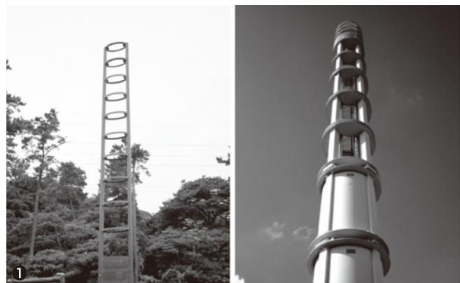
①日本鉄塔工業株式会社在籍時に開発した景観対応型通信鉄塔の開発。アンテナや外部機器などを内包する仕組みを特徴としており、大手通信会社に採用された。
